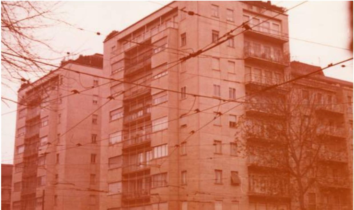
Figura A20: diramazione dai viali Piave/Premuda verso corso Concordia (p.ta Manforte/p.za Tricolore), novembre 1977: durante la trasformazione, ibrido di sospensioni per trolley e per pantografo ) e insolita abbondanza di ferri di usura sugli scambi (rif. figura 8.2 C); dopo la trasformazione, il solo binario direzione periferia di corso Concordia fu usato pochissimo e solo per pochi metri come binario di scarto
