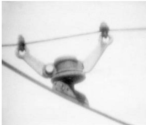
Figura A30: sospensione TIBB per curva: un insolito adattamento per tirante trasversale non interrotto (piazzale Bacone, 1977)
